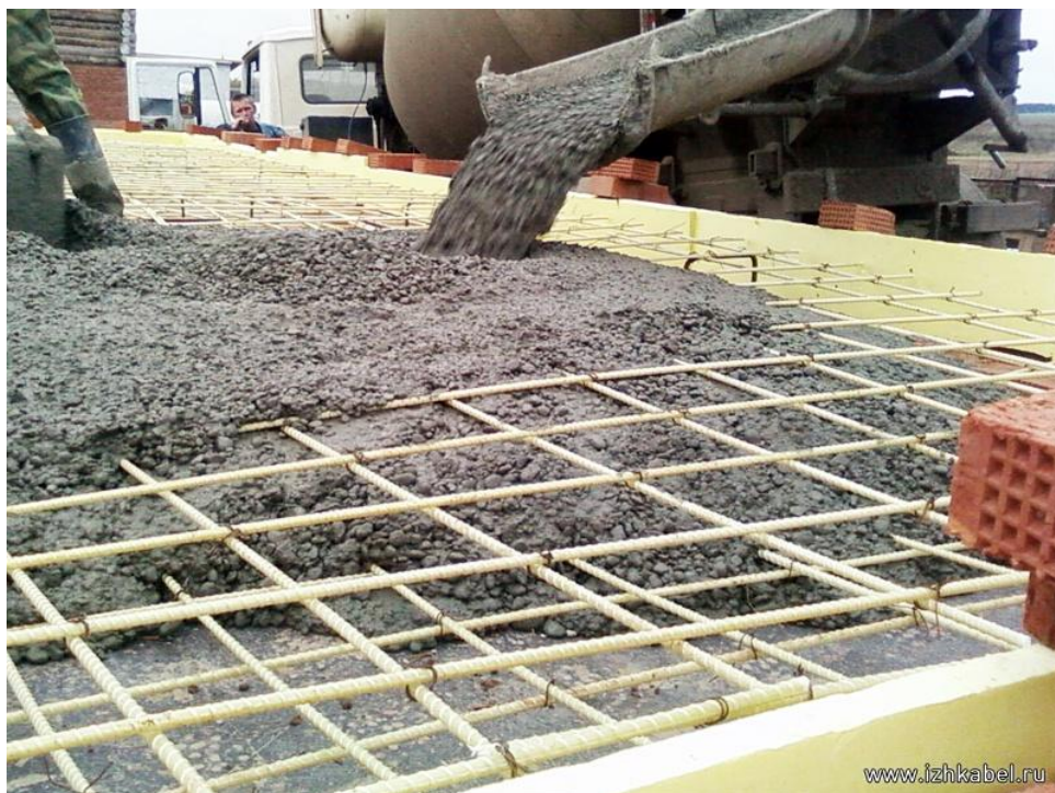
Рис. 1 – Использование в плитах перекрытия
