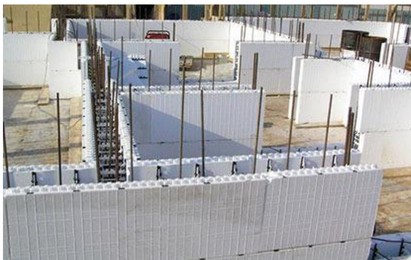
Рис. 4 – Возведение домов из несъемной опалубки
