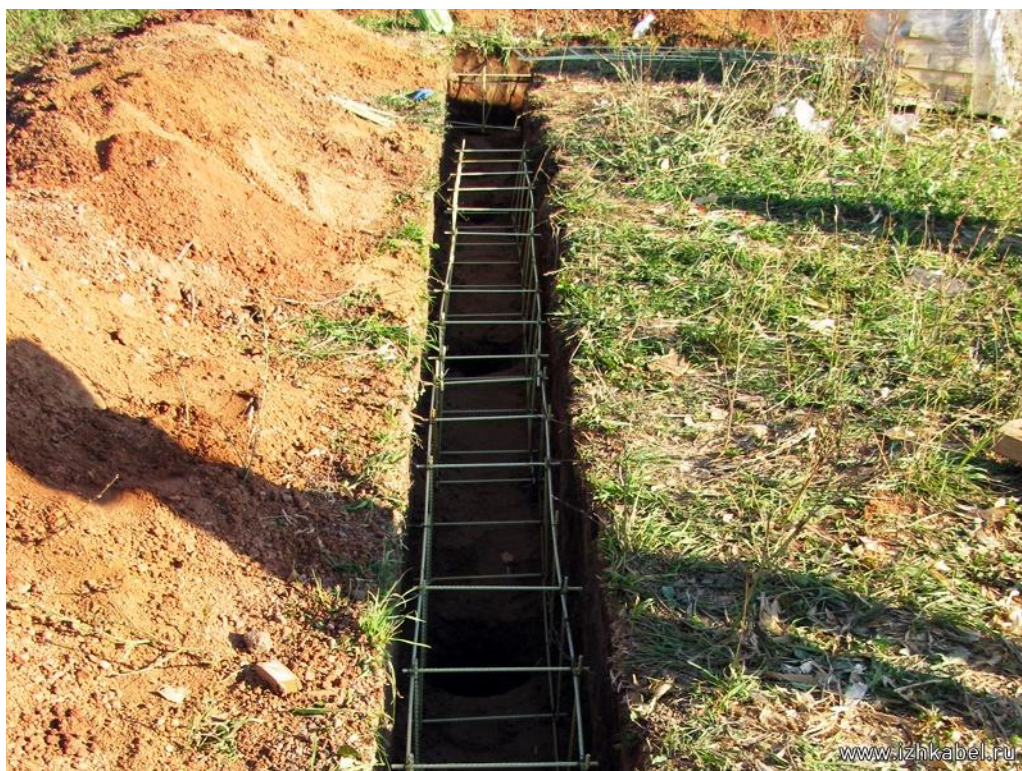
Рис. 2 – Устройство в монолитных фундаментах
