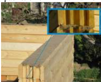
Рисунок 2 – Прокладка межвенцового утеплителя
