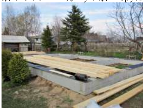
Рисунок 1 – Устройство столбчатого фундамент с монолитным ростверком
