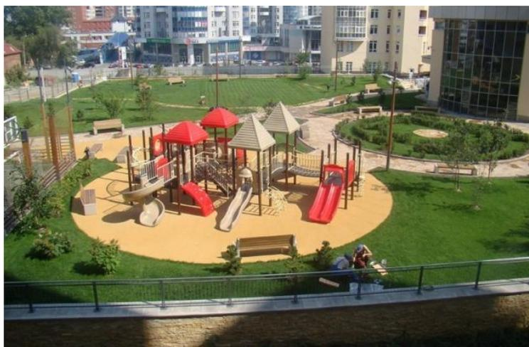
**Рисунок 3** - ЖК «Тихвин Клуб», г.Екатеринбург. Эксплуатируемая зеленая кровля на крыше подземного гаража спортивно-оздоровительного комплекса.
