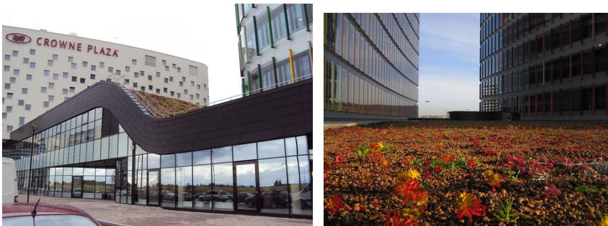
**Рисунок 14** – а) Крыша многофункционального комплекса Аэропортсити в Санкт-Петербурге, б) экстенсивная кровля комплекса из очитков
