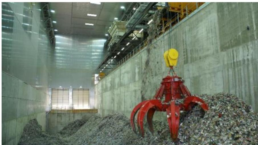
Рисунок 2 – Приемный бункер
