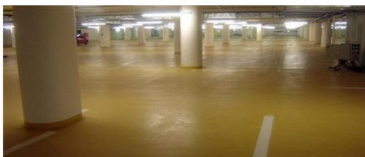
Рисунок 2 – Применение бетонного наливного пола с топпингом
