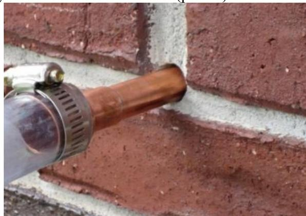
Рисунок 2 – Инъекцирование жидкого утеплителя.
