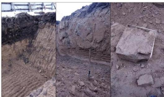
Рисунок 1.2 -Котлован и отобранный образец грунта
