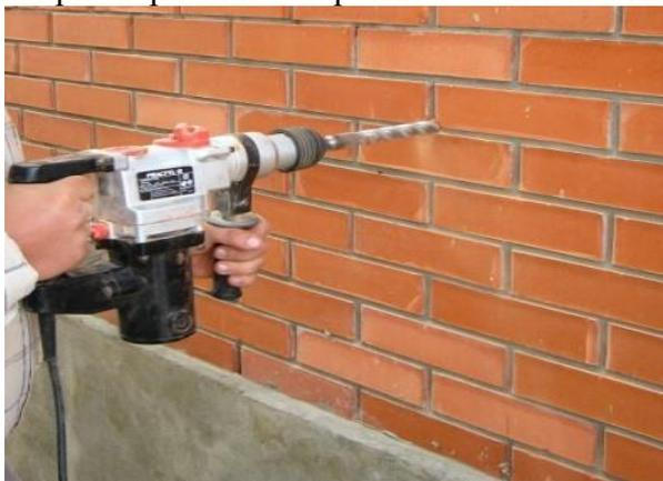
Рисунок 1 – Сверление отверстий в швах кирпичной кладки.
