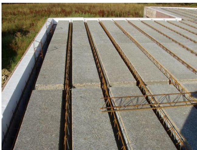
Рисунок 2-Опалубка перекрытий образованных между пустотными коробами;
