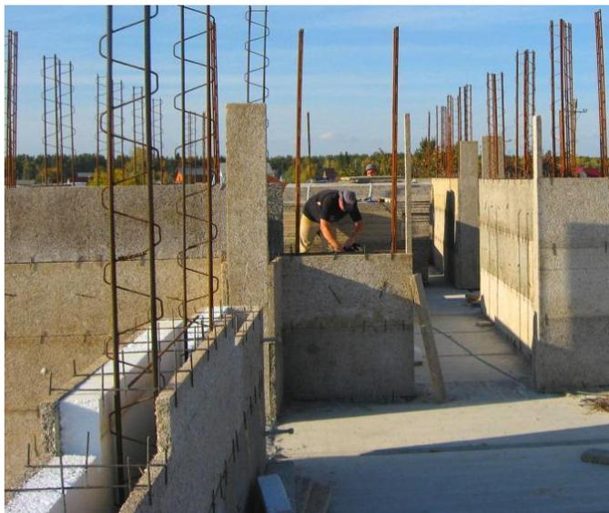
Рисунок 1-Опалубка наружных стен
