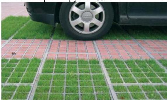
Озелененная площадь отлично пропускает воду, за счет распределения нагрузки по большой поверхности и подвижности решетки ТТЕ грунт не уплотняется, сохраняет свою естественную гидроактивность.
