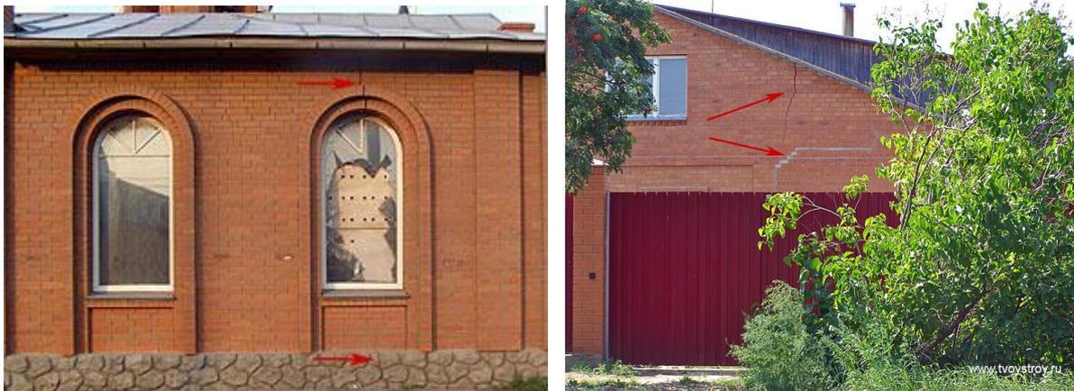
Рисунок 1 – Последствия воздействия сил морозного пучения на здание
