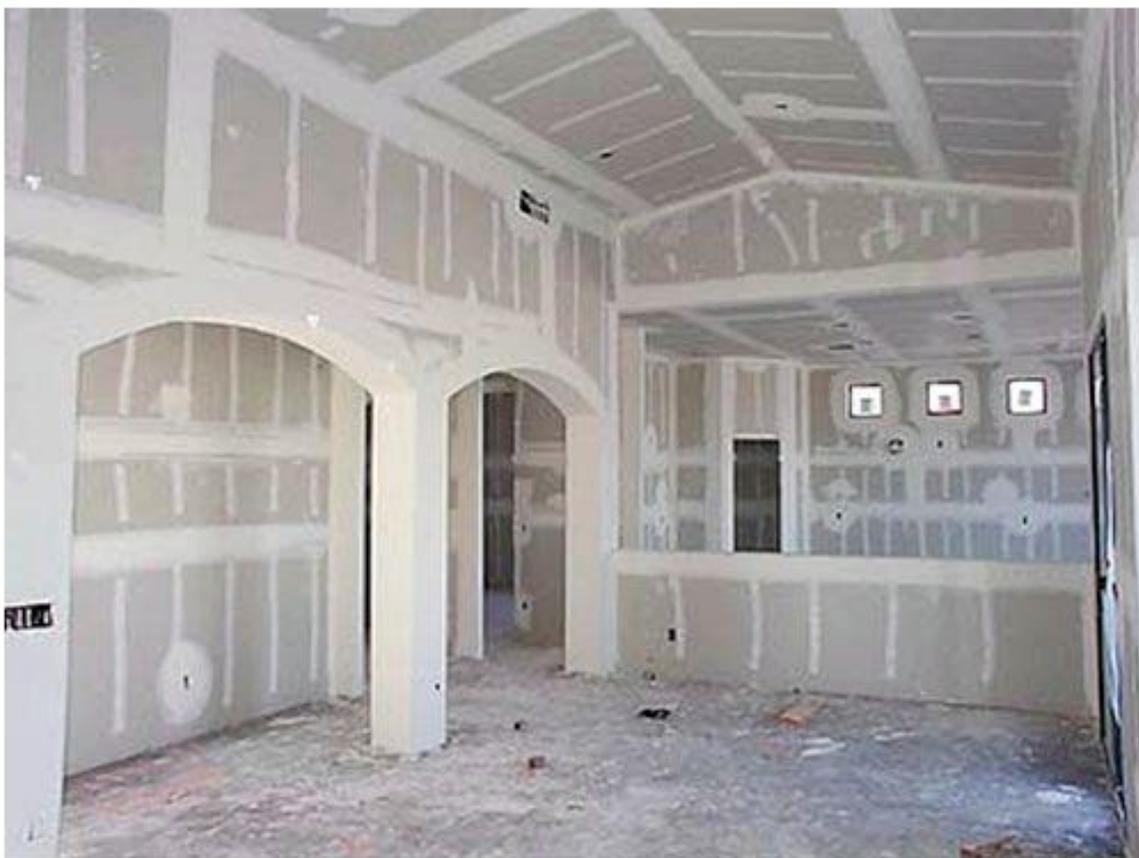
Рисунок 2 – Пример использования гипсокартонных плит в качестве сухой штукатурки.
