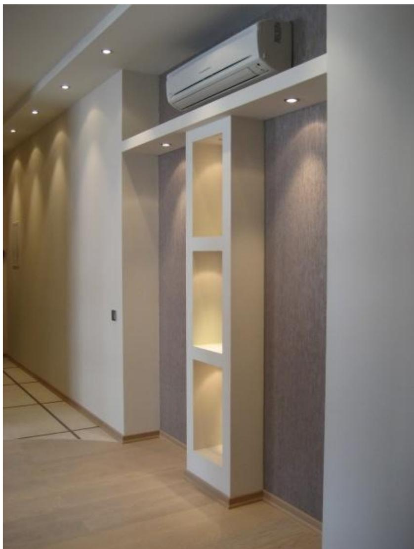
Рисунок 1 – Световое решение в гипсокартонной конструкции.
