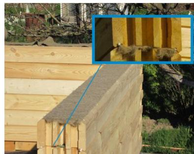
Рисунок 2 – Прокладка мазевнцового утеплителя
