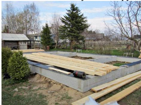
Рисунок 1 – Устройство столбчатого фундамент с монолитным ростверком
