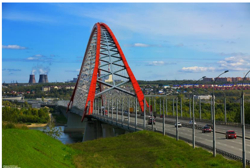
Рисунок 4 – Бугринский мост через реку Обь (г.Новосибирск)
