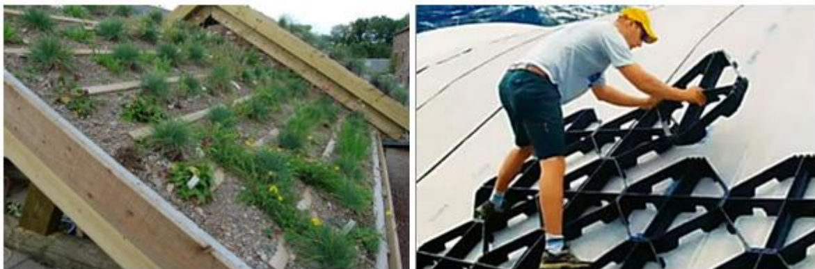
Рисунок 14 - Поперечные фиксаторы, предотвращающие сползание почвы и растительности при устройстве зеленой кровли
