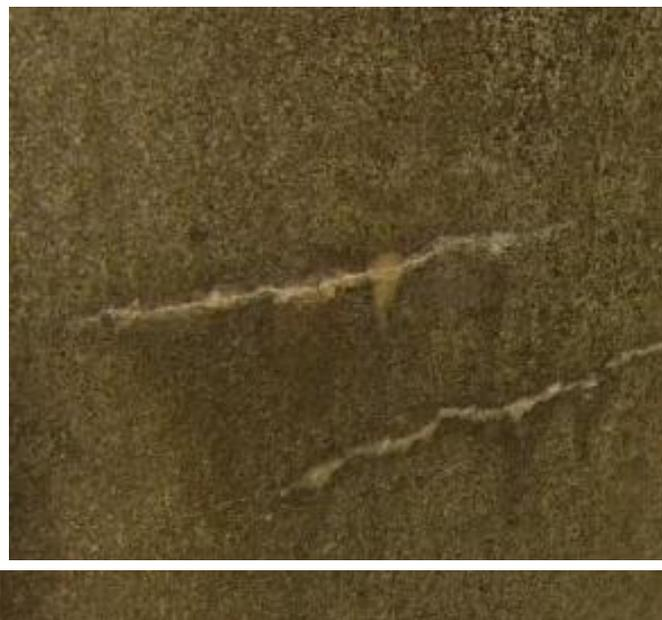
Рисунок 2 – Вид стены после её восстановления бактериями
