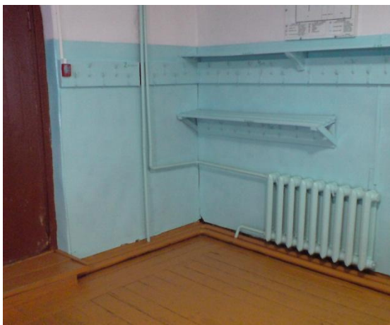
Рисунок 2 - Приборы отопления в учебном корпусе
