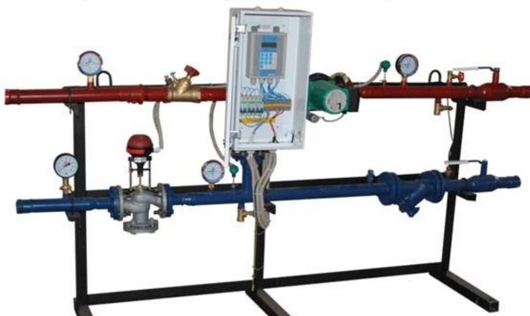
Рисунок 2 - . Внешний вид блочного модуля управления
