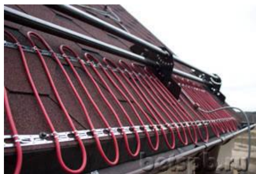
Рисунок 2 – Схема прокладки системы кабельного обогрева водостока и крыши.
