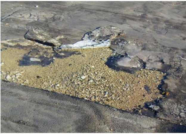
Рисунок 1 – Разрушение верхнего слоя кровли, пузыри, заплатки (в верхнем левом углу кадра)
