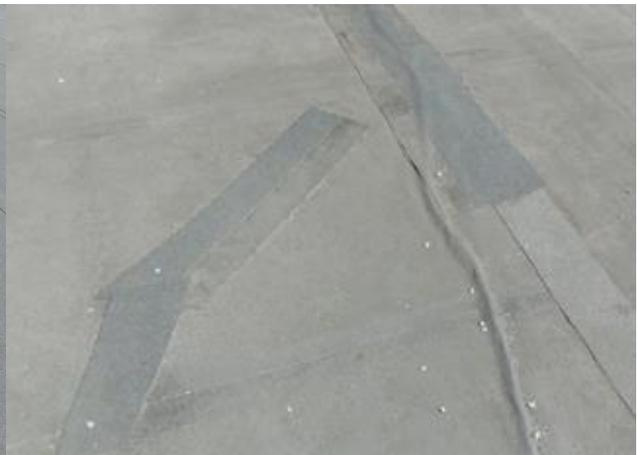
Рисунок 4 – Вздутие кровли следы ремонта трещин в кровле
