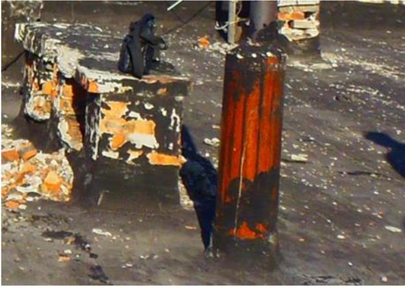
Рисунок 7 – Не установлена стальная гильза с фланцем и коническим фартуком из оцинкованной стали в месте пропуска через кровлю трубы
