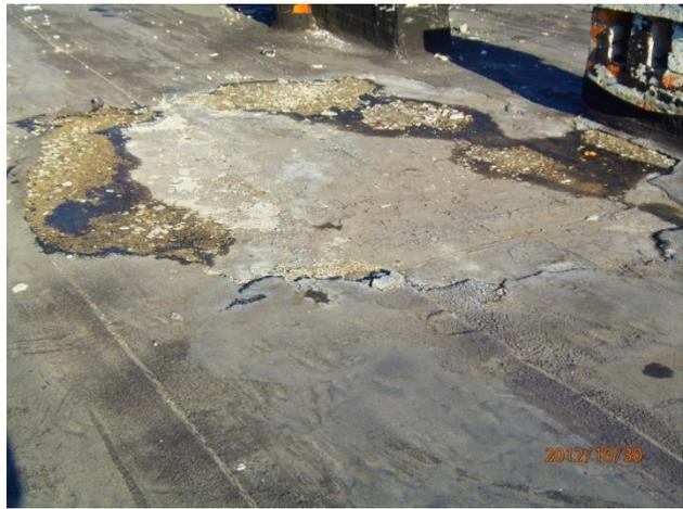
Рисунок 2 – Разрушение верхнего слоя кровли
