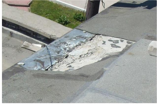
Рисунок 8 – Отрыв водоизоляционного ковра на карнизном участке
