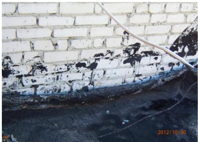
Рисунок 6 – Отслоения рулонного ковра от вертикальной поверхности стенки выхода на кровлю, данная поверхность не оштукатурены на высоту заведения кровли
