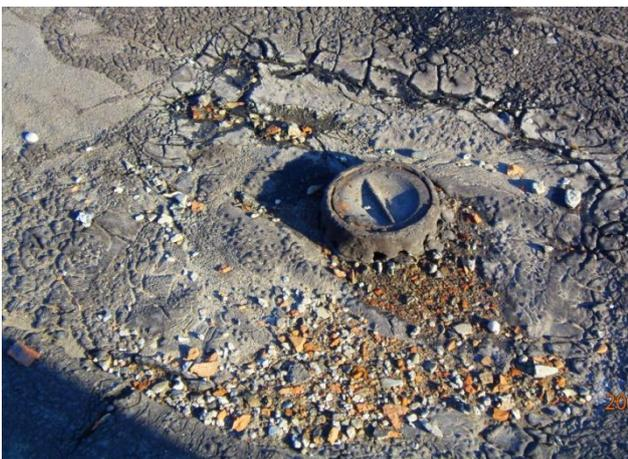
Рисунок 5 – Неровности, трещины в слое мастики, мусором забито часть отверстий водоприемной воронки внутреннего водостока
