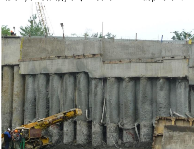
Рисунок 2 – Внешний вид «одевающихся» подпорных стенок на дорогах Сочи
