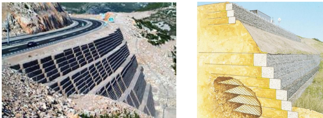
Рисунок 3 – Внешний вид армогрунтовых подпорных стенок
