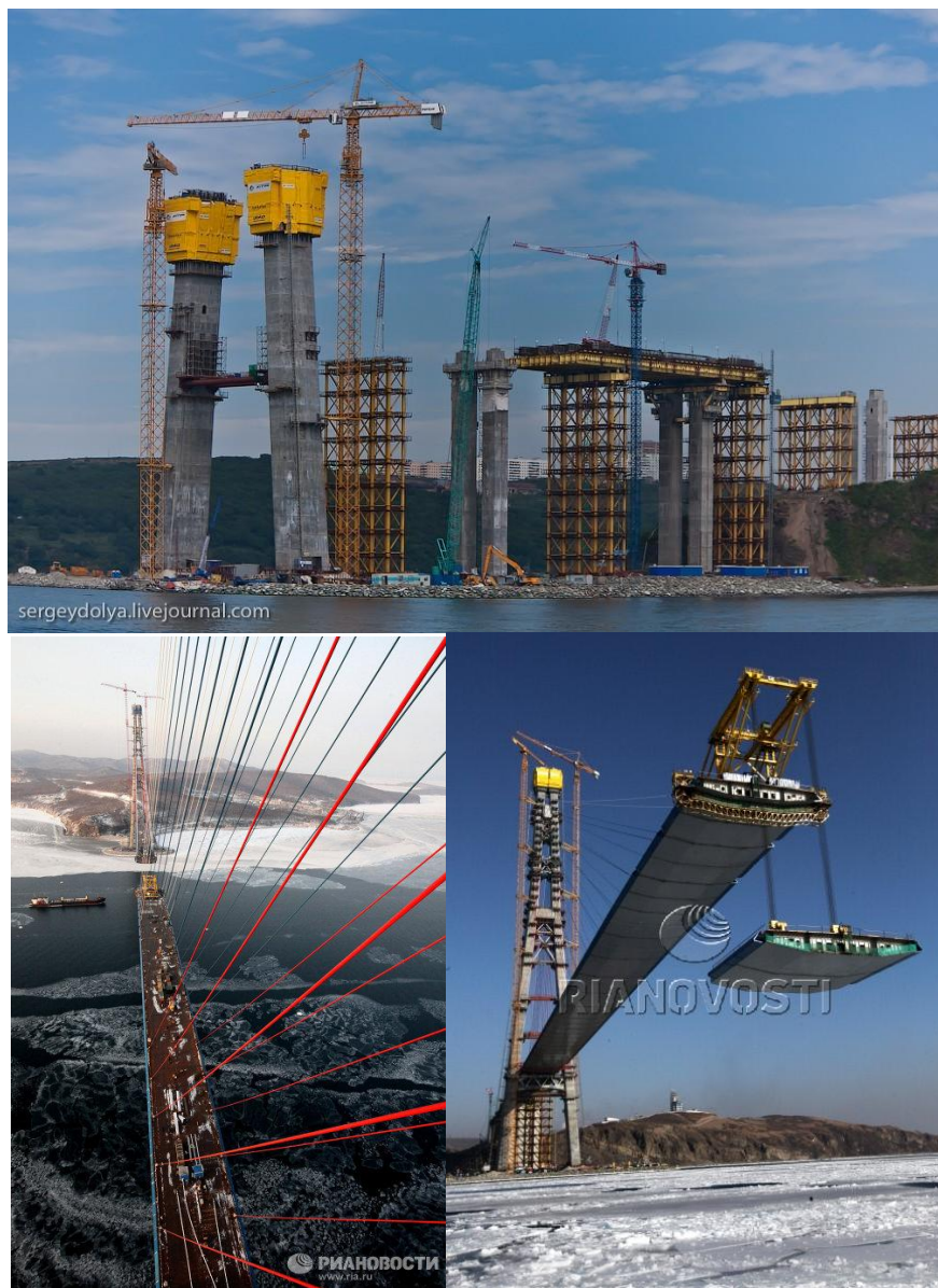
Рисунок 3 – Строительство вантового моста на о.Русский
