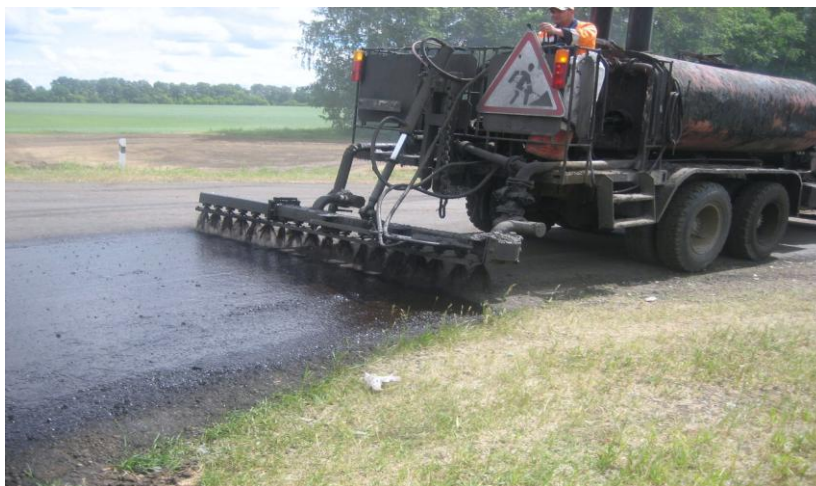
Рисунок-1 - Розлив битумной эмульсии
