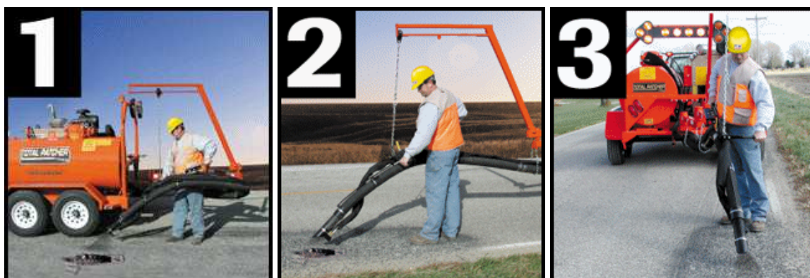
Рисунок 1 – технологический процесс ремонта выбоины струйно-инъекционным способом
