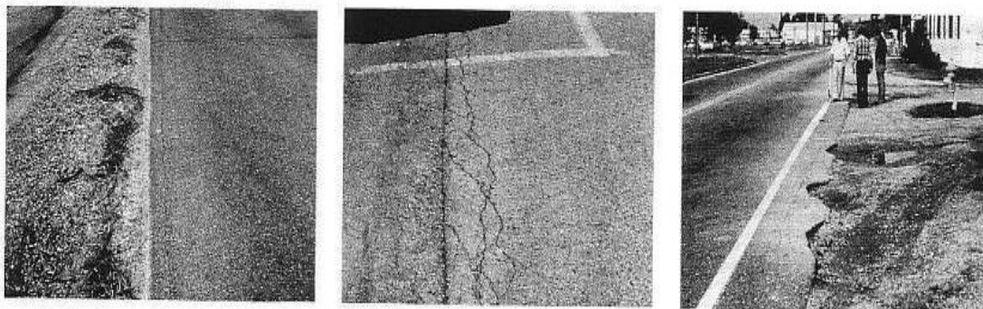
а) легкое повреждение б) повреждение средней тяжести в) тяжелое повреждение Рисунок 3 – Краевые трещины
