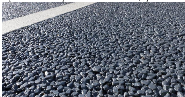
Рисунок 2 – Асфальтобетон Тортмiх способный пропускать воду
