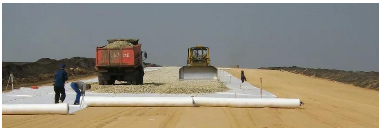
Рисунок 3 - Разделение слоев песка и щебня при помощи геотекстиля
