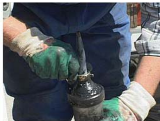
Рисунок 2 – Набор герметика в шприц
