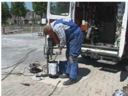
Рисунок 1 – Смешивание герметика с отвердителем
