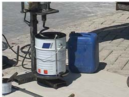
Рисунок 1 – Смешивание герметика с отвердителем
