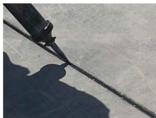
Рисунок 3 – Заливка швов и трещин герметиком
