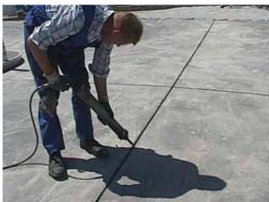
Рисунок 3 – Заливка швов и трещин герметиком
