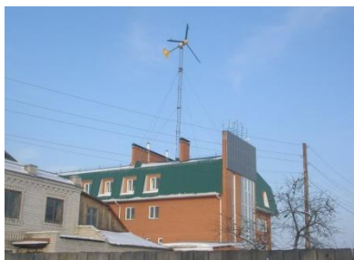
Рисунок 2 – Экодом в Барнауле. Установка оборудования и работа алтайских специалистов во главе с профессором Виктором Федяниным обошлась в сумму менее одного миллиона рублей, в то время как подключение к сетям традиционной энергии обошлось бы в несколько миллионов рублей.
