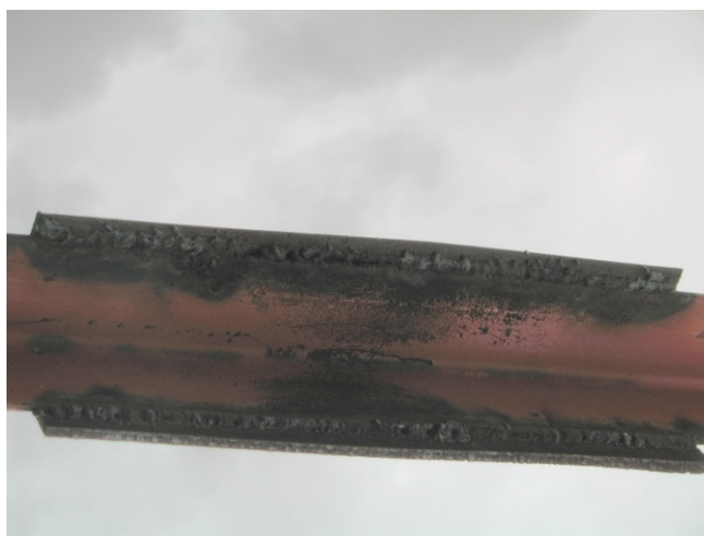
Рисунок 2 - Непроектное усиление погнутого раскоса башни БС № 41669 «Старотырышкино»
