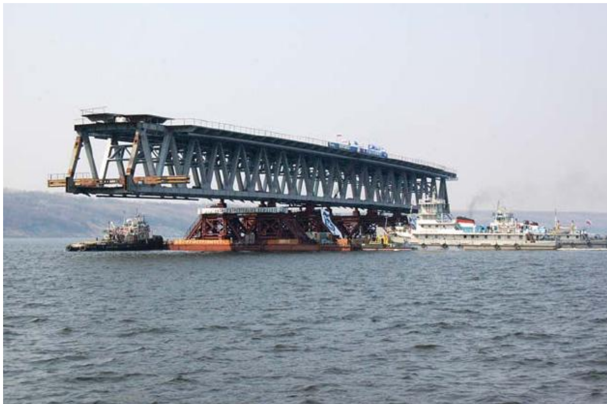
Рисунок 1 - Перевозка пролета по воде на двух плавучих опорах
