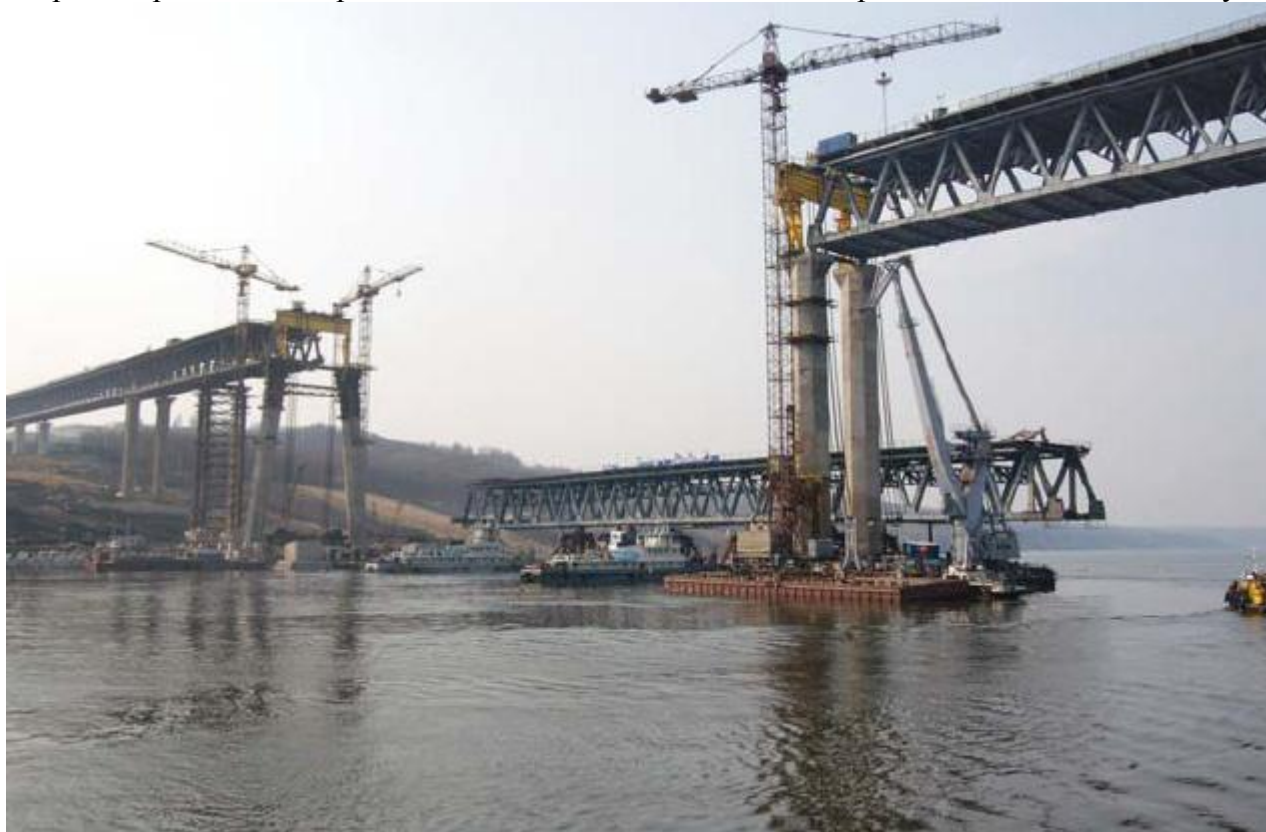
Рисунок 2 - Монтаж пролета моста
