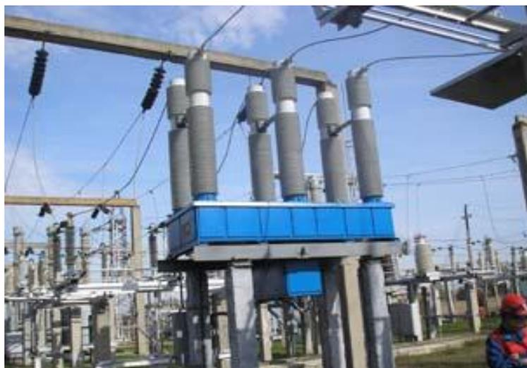
Рисунок 2 – Выключатель вакуумный, 110 кВ
