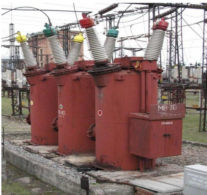
Рисунок 1 – Выключатель баковый масляный, трехфазный, на напряжение 110кВ
