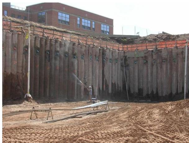
Рис.2 – «Стена в грунте» выполненна по свайной технологии
