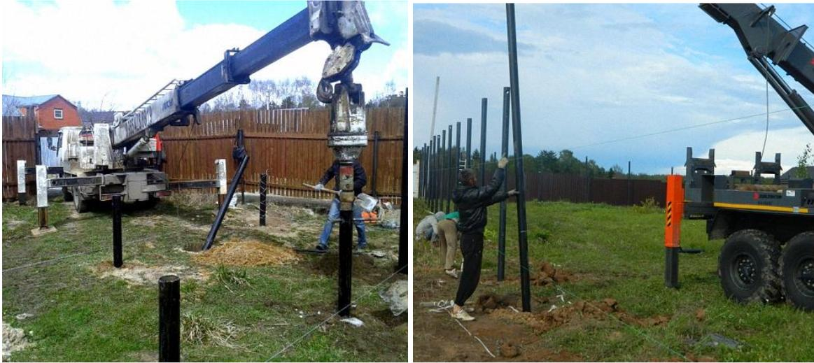
Рис. 2 – Применение многолопастные винтовых сваи
