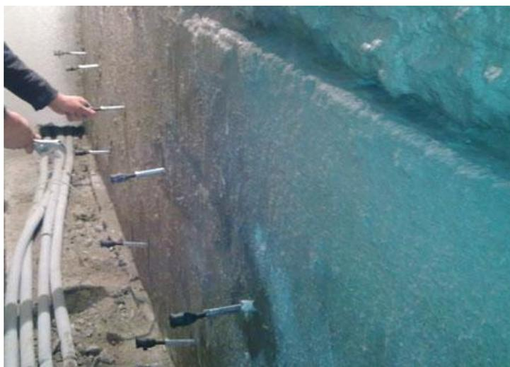
Рис. 1 –Инъекционный метод восстановления горизонтальной гидроизоляции фундамента
