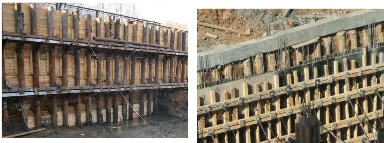
Рис.2 – Усиление ограждения грунтовыми анкерами.
