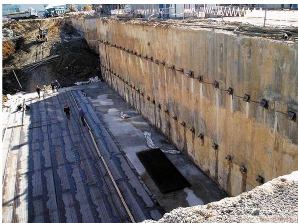
Рис. 1 – «Стена в грунте» выполненная по траншейной технологии
