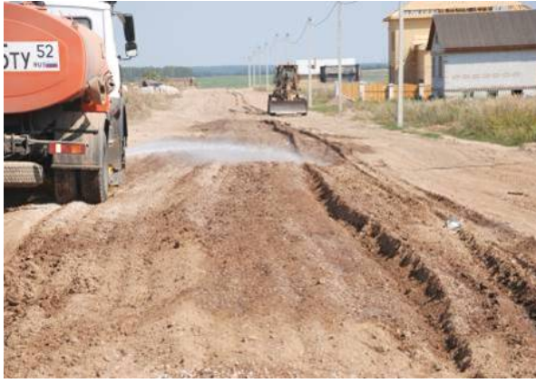
Рисунок 1 – Рыхление, перемешивание, планирование, внесение растворов.
