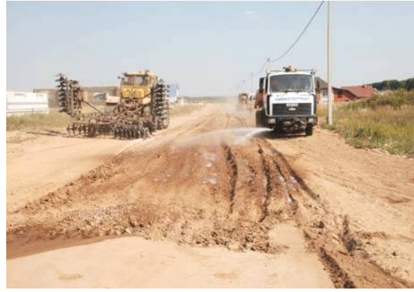
Рисунок 1 – Рыхление, перемешивание, планирование, внесение растворов.
