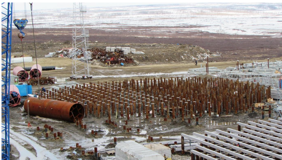
Рисунок 1 Свайное поле под резервуар V=1000\text{м}^3 . Буроопускной метод
