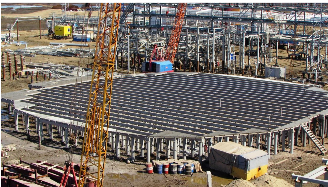
Рисунок 2 Свайное поле под резервуар V=1000\text{м}^3 . Буроопускной метод. После выполнения АКЗ
