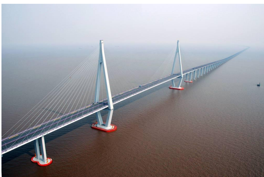
Рисунок 4 – Мост Ханчжоу в Китае
