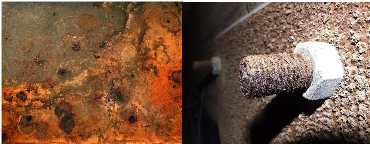
Рисунок 1 – Ржавчина, самый распространённый вид коррозии. Коррозия металла.
