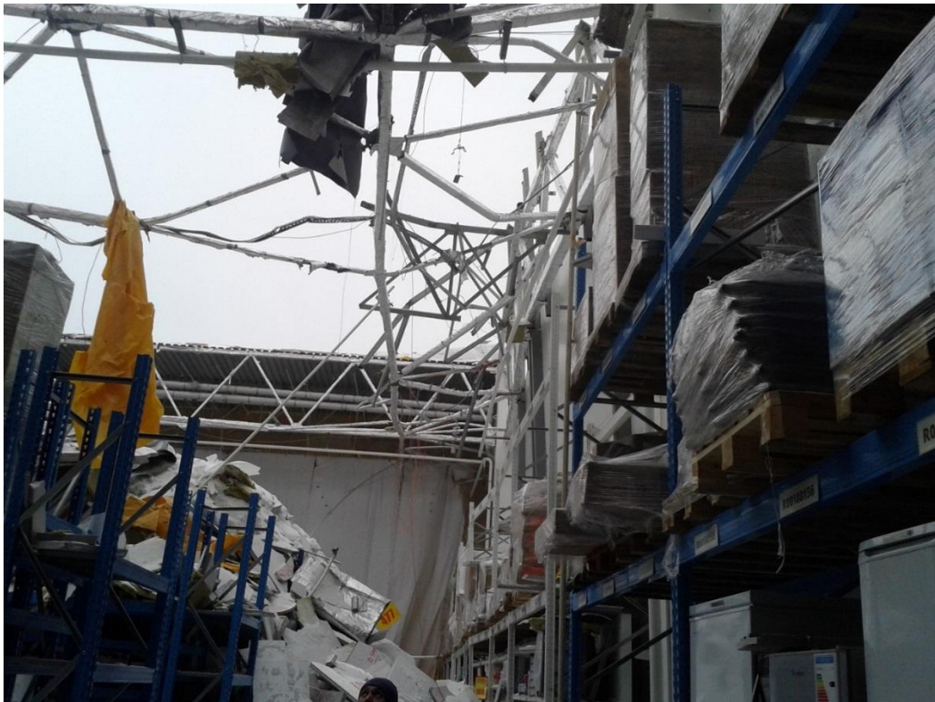
Рисунок 1 - Крыша торгового центра "Галактика" после обрушения.
