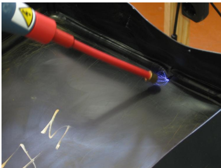
Рисунок 2 – Проверка плотности сварных швов
