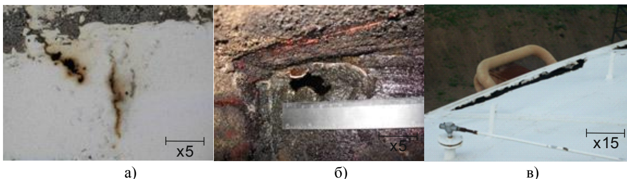
Рисунок 1 – Коррозионная язва: а – поверхностная; б, в – сквозная
