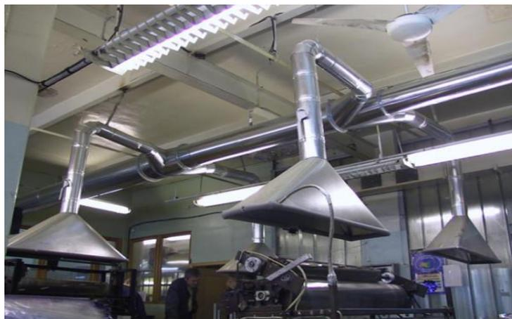
Рисунок 1 - Принудительная промышленная вентиляция и кондиционирования с зондами местной вытяжки
