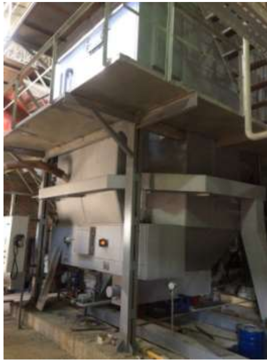
Рисунок 2 – Котлы КЕ-10-1,4 реконструированные с установкой вихревой топки «Торнадо».
