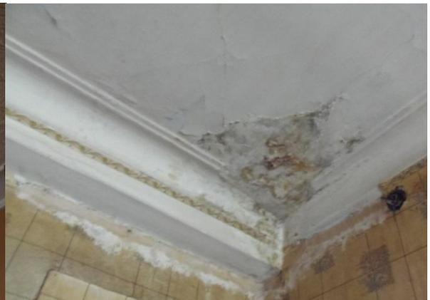
Рисунок 6 – Диагональные и продольные трещины в штукатурном слое перекрытия
