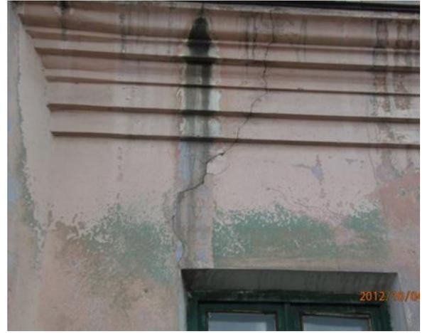
Рисунок 2 – Вертикальная трещина и следы замачивания в карнизной части стены
