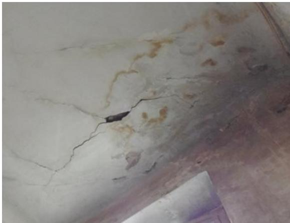
Рисунок 3 – Следы протечек на чердачном перекрытии (в лестничной клетке); трещины в штукатурном слое
