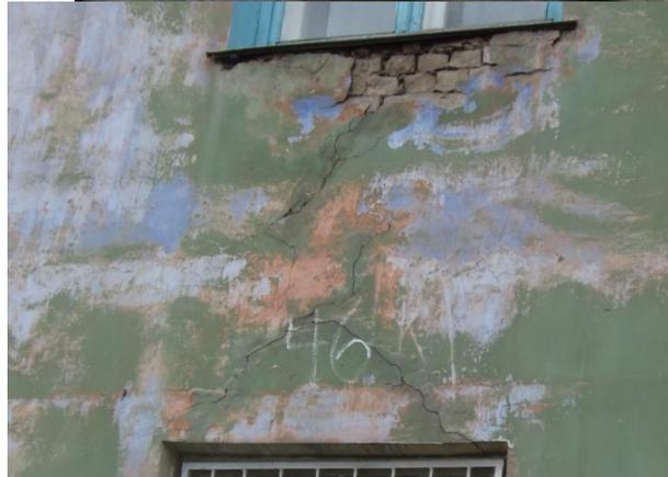
Рисунок 3 – Трещины в цоколе и подоконной части стен
