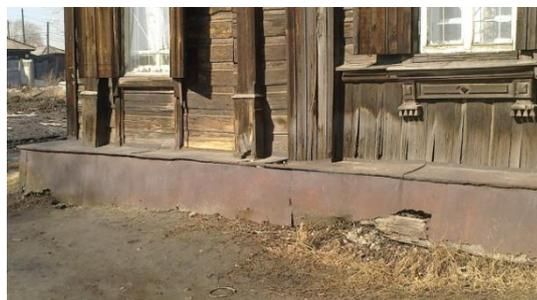
Усиление стен заключается в обвязке бревенчатого сруба по канавкам с обеих сторон бревна глубиной, равной диаметру каната. По всей дине бруса просверлить отверстия. Произвести пропитку элементов обвязки (при помощи иньектора) заливочным компаундом на основе
