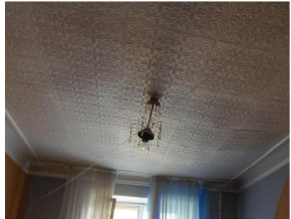
Рисунок 4 – Прогиб перекрытия больше предельного по СП 20.13300.2011
