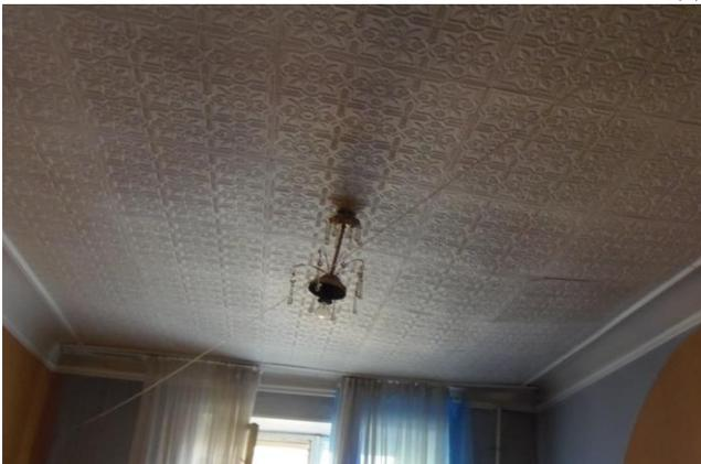
Рисунок 5 – Прогиб перекрытия больше предельного (квартира 6)
