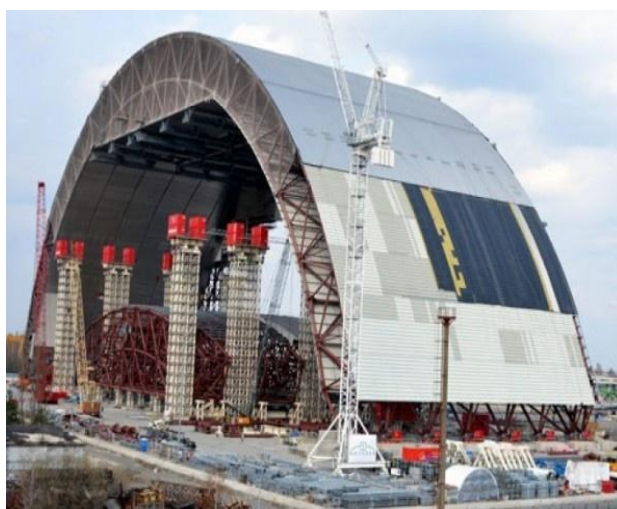
Рисунок 3 – Фотография со строительства «Саркофага»
