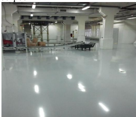
Рис.3 Наливной пол в производственных помещениях машиностроения
