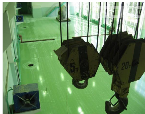
Рис.4 Наливной пол на предприятии
