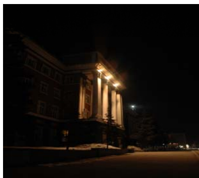
Краевой дом правосудия г.Барнаула. пр.Ленина,25 Применяются: галогеновые светильники
